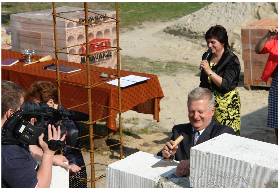
Wmurowanie kamienia węgielnego pod budowę sali sportowej przy szkole podstawowej w Świdrach – 2009.
