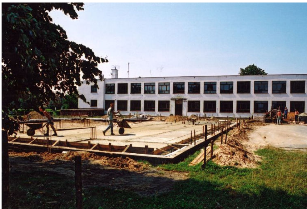
Budowa sali gimnastycznej w Gołębkach.
