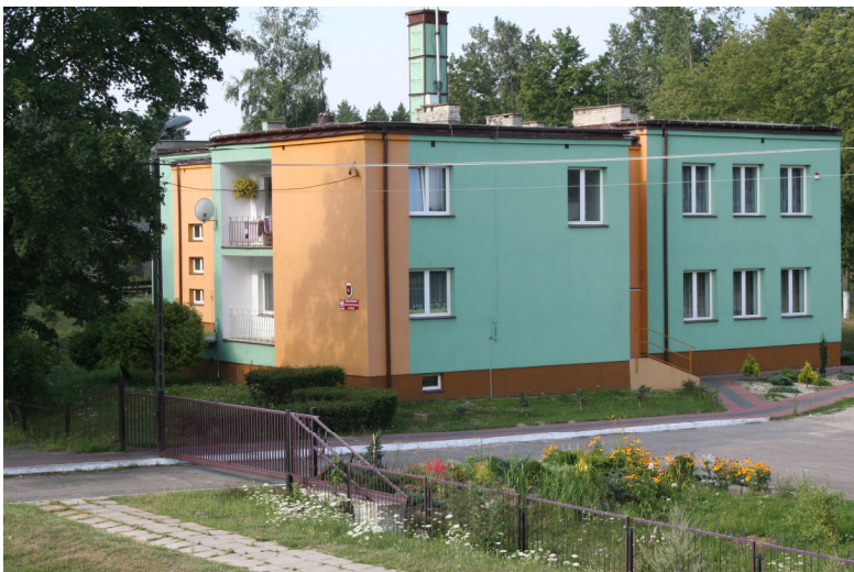
Szkoła Podstawowa w Świdrach po remoncie
