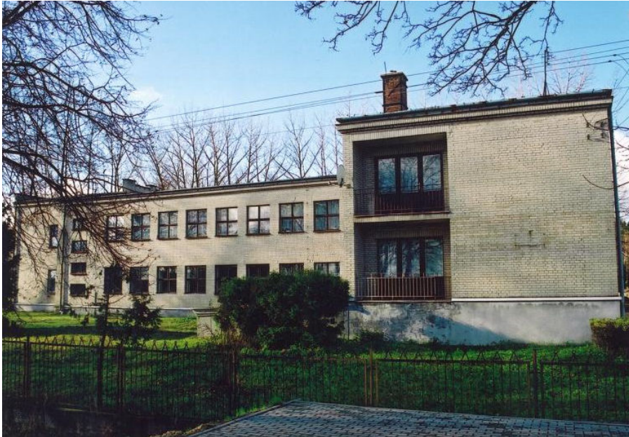
Szkoła Podstawowa w Świdrach przed remontem
