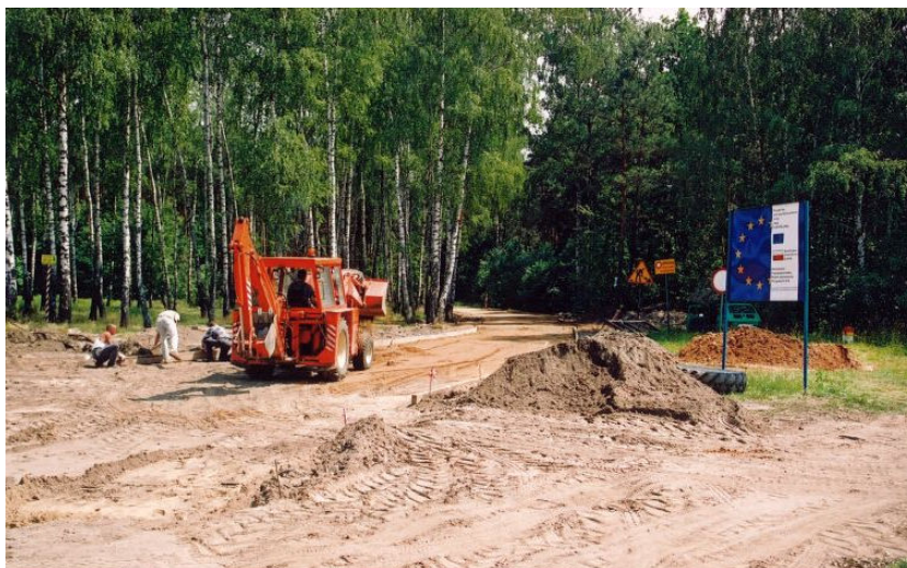
Budowa drogi Świdry – Ryżki
