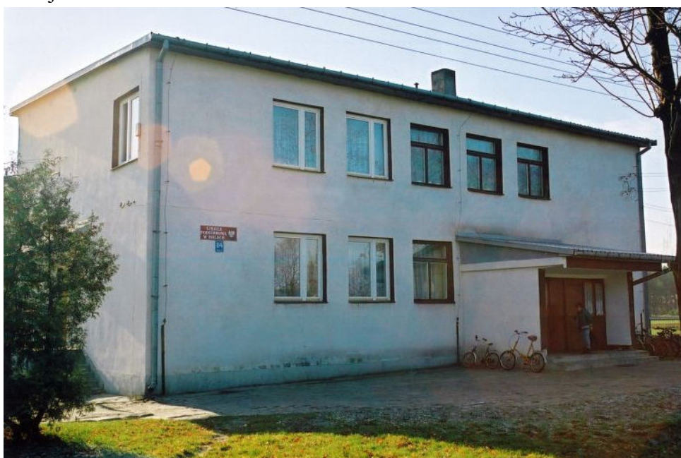
Szkoła Podstawowa w Rolach przed remontem
